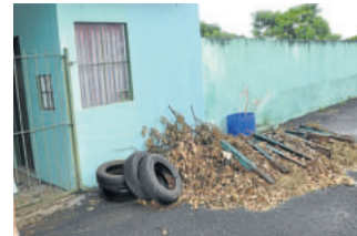
Estado de abandono é visível. Lixo é acumulado na área interna
