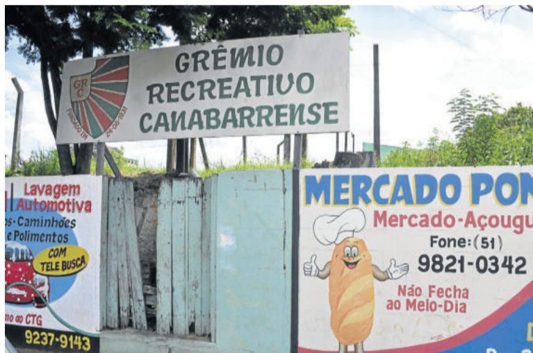
Fachada na Rua Dom Pedro II demonstra o estágio do clube
