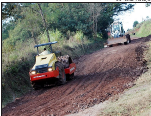
Obras nas estradas da Linha Vale Harmonia
