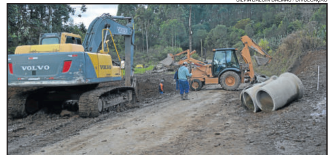
Iniciou essa semana as obras de asfaltamento na Rua Pedro Ângelo Guerra
