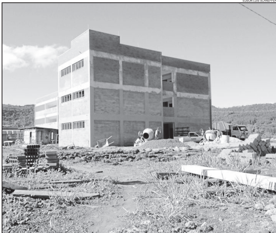
Escola Municipal Vila Schmidt está sendo ampliada em três pisos
