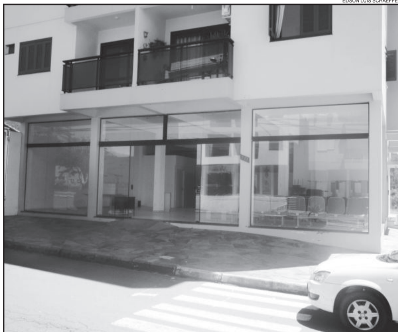
A Câmara de Vereadores funcionará na antiga sede da Previdência Social, na Avenida 1 Leste, 961
