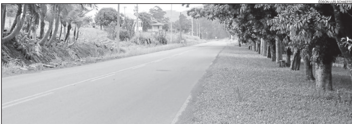
Pista de caminhada, que depende de liberação do Daer, será instalada ao longo da área verde da ERS-419
