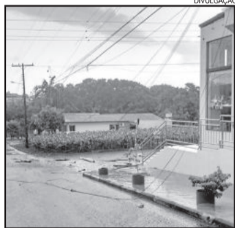
Telhas atingiram os fios e ficaram espalhadas na rua
