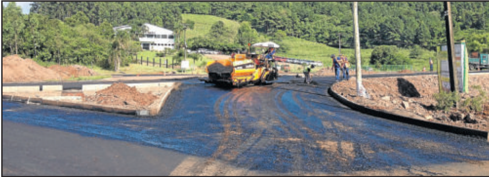
Máquinas aplicam asfalto
