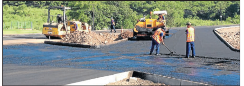
Trecho requer atenção devido às obras
