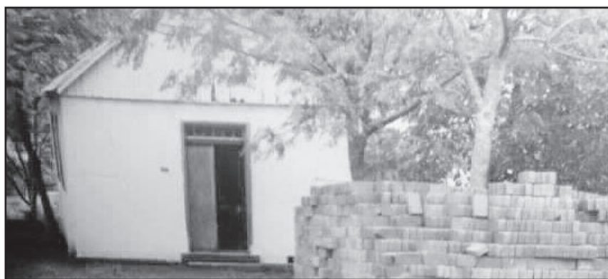
Primeiro prédio da Escola Gomes Freire em 1941
