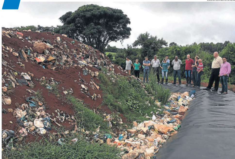
Projeto da Vala 3 já está na Fepam desde julho de 2015
