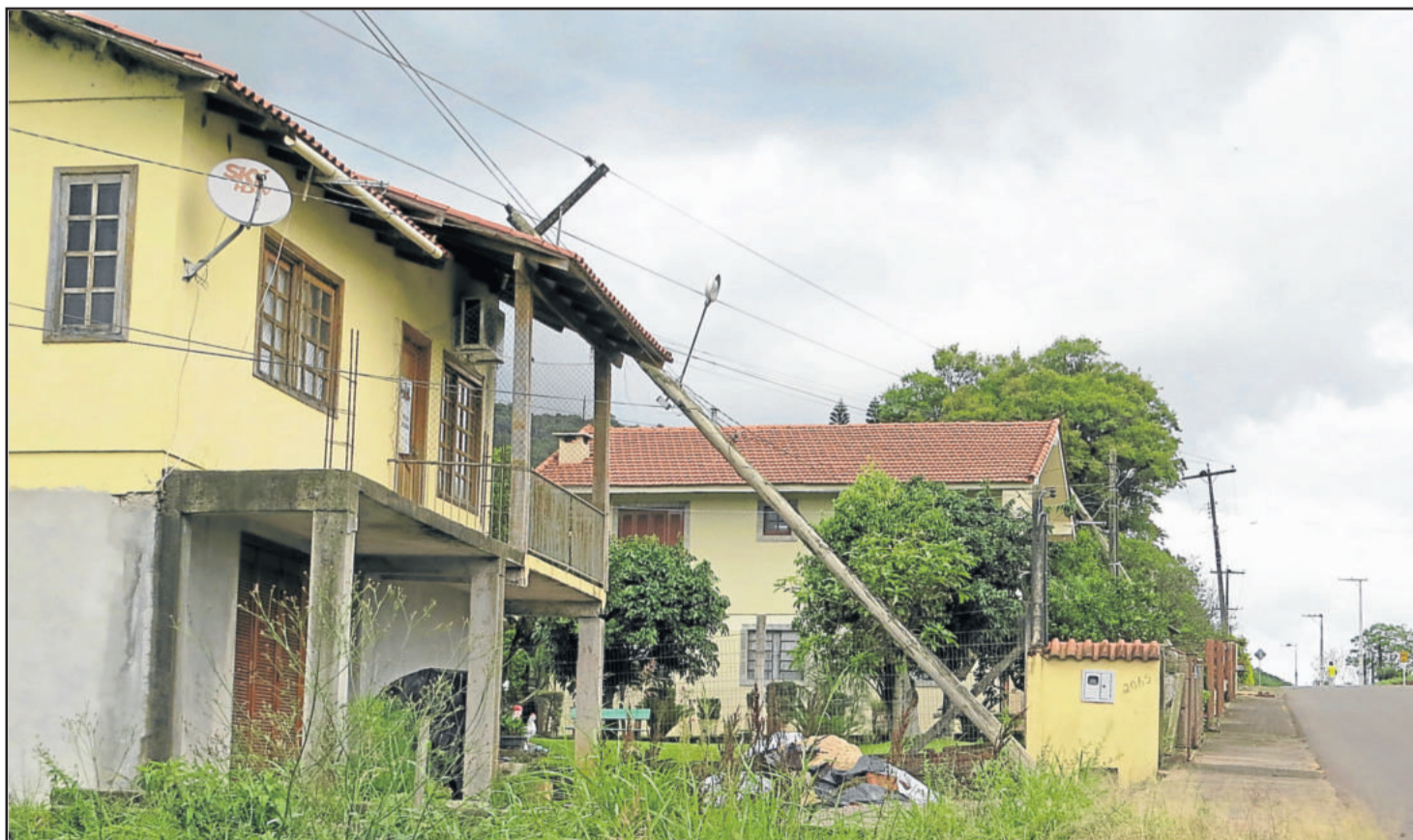
Em Colinas, postes caíram, alguns quase dentro do pátio de residências
