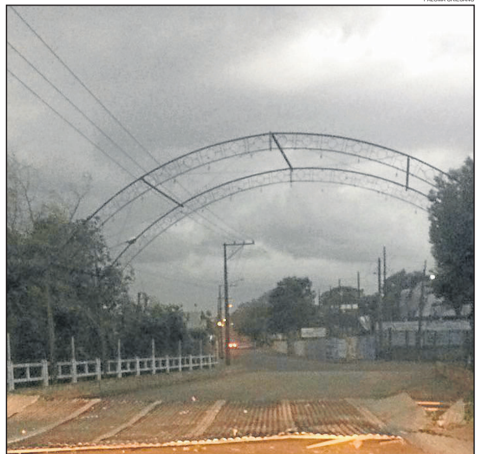
O telhado da sede social do Canabarrense foi arrancado durante o temporal e bloqueou o viaduto sobre a ferrovia em Canabarro, na Rua Dom Pedro II
