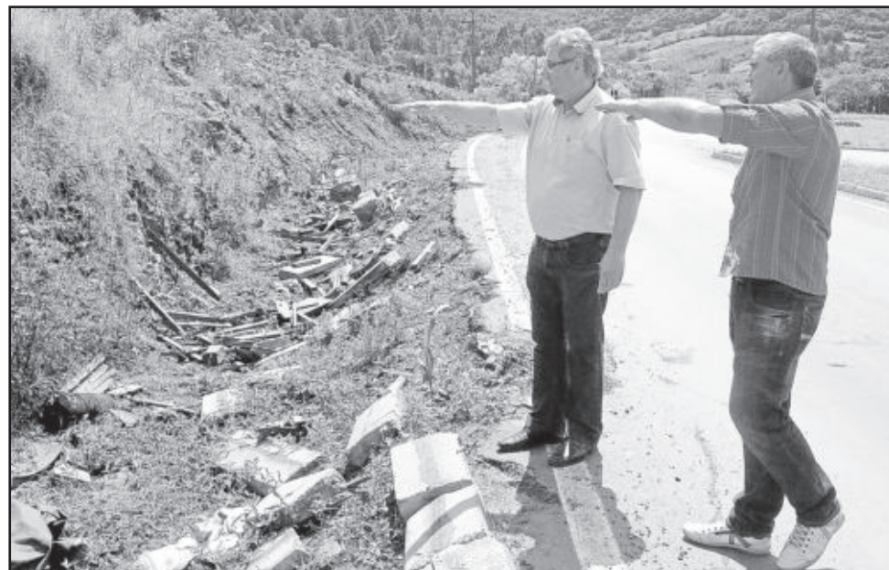
Vala na lateral da Rota do Sol será fechada e pavimentada
