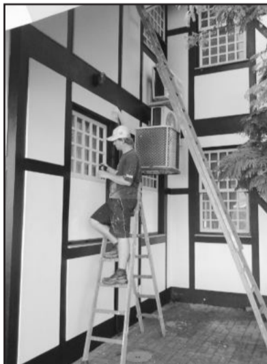
Centro Administrativo foi revitalizado
