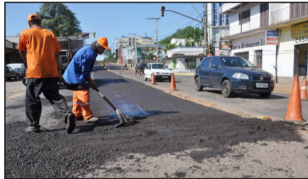
Aplicação de camada asfáltica na Av. Pasqualini
