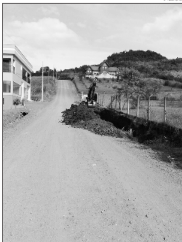
Obras de asfaltamento começaram nesta semana
