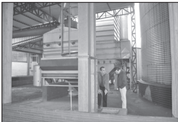
Prefeito (e) vistoriou as instalações do prédio
