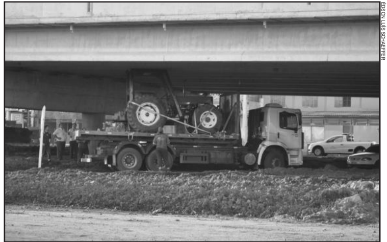
Veículos com altura superior a 3,5 metros, como o caminhão transportando o trator, podem ficar presos entre as vigas da elevada ao fazer o retorno pelo local
