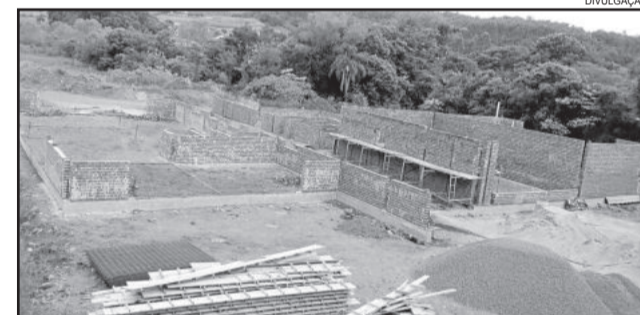
Obras da nova Sede Administrativa seguem em ritmo acelerado
