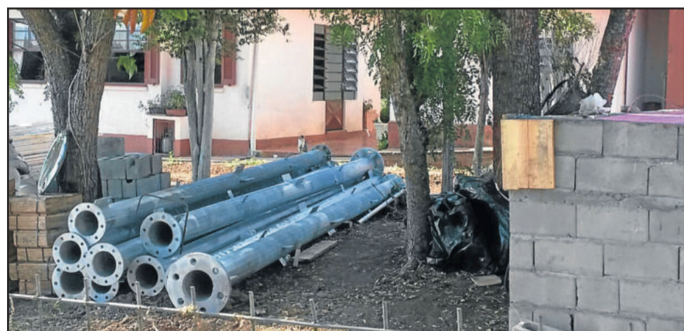
Tubulação para montar a antena já se encontra no terreno
