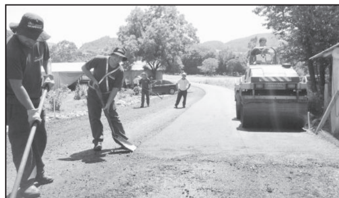
Asfalto está na fase final
