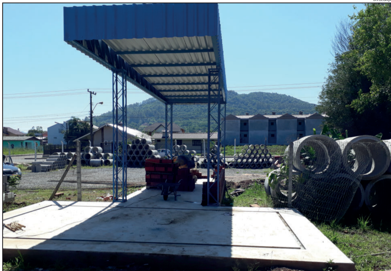
Local está quase pronto para receber a instalação do tanque
