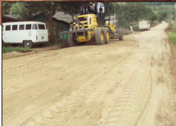
Ruas da zona urbana, como no Bairro Morro Bonito, também são recuperadas
