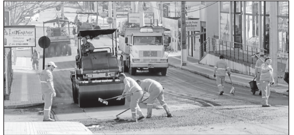
Obras mudaram rotina no Bairro Languiru
