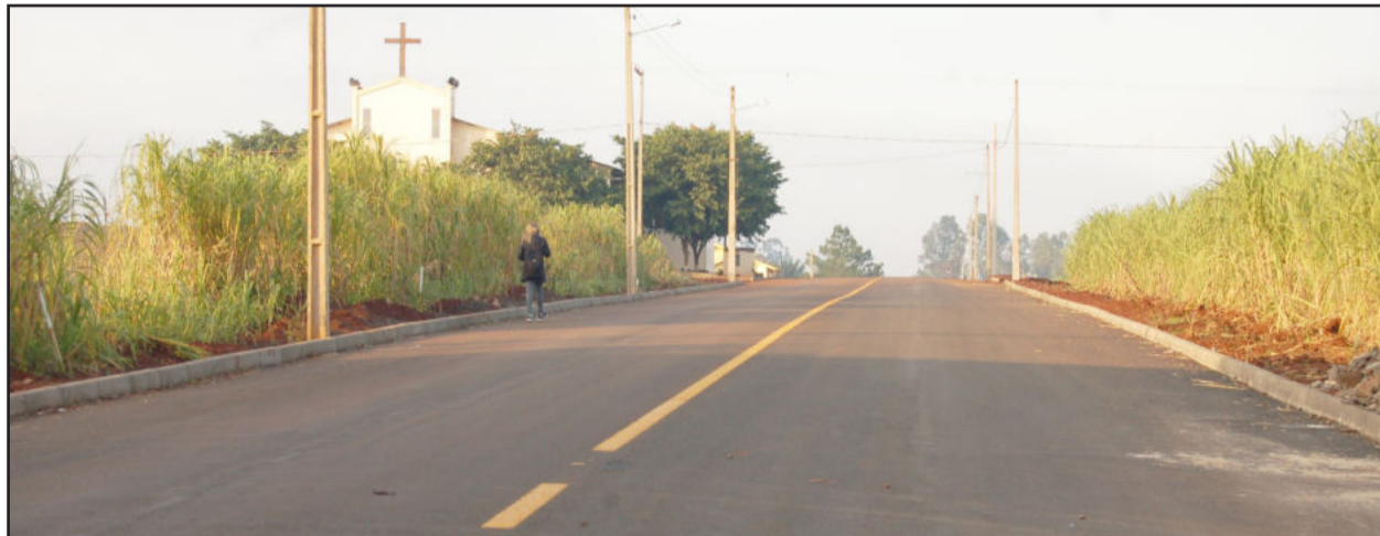
Pavimentação asfáltica da Leopoldo Klepker interliga dois pontos do Bairro Alesgut
