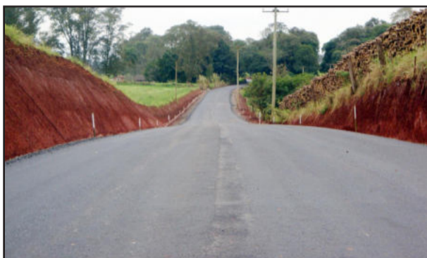
Obra de pavimentação já tem 1,5 quilômetro concluído
