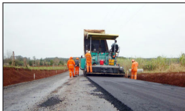
Equipes trabalhando no asfaltamento
