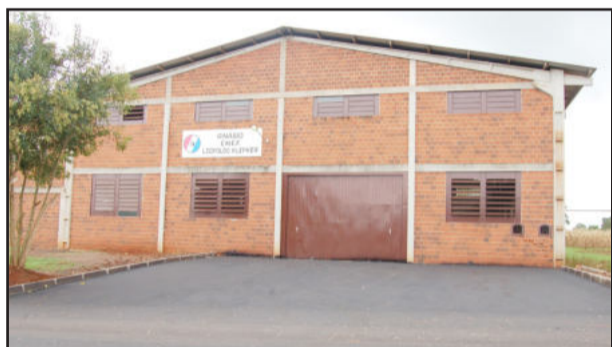
Acesso ao ginásio da Escola foi pavimentado
