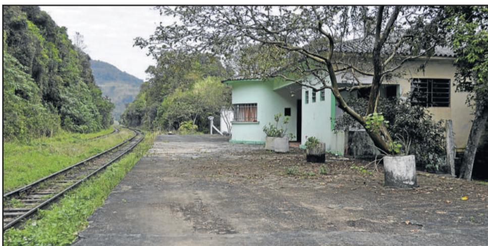
Sede da estação férrea, em Colinas
