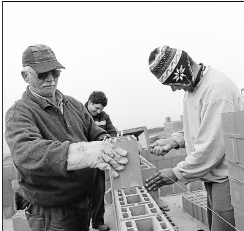
Com mão de obra regional, Tercon ergue a primeira casa no Projeto Habitacional de Estrela
