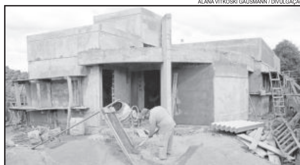
Construção do CRAS está em andamento no Centro Administrativo
