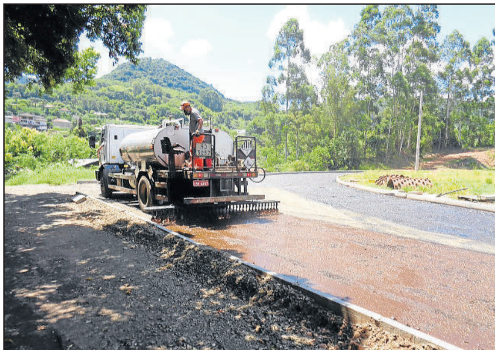
Empresa responsável pela obra efetuou a imprimação da base na pista atlética
