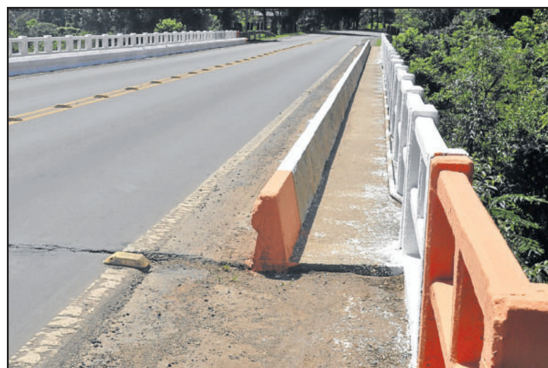
Pontes receberam pinturas. Na foto, ponte sobre o Arroio Boa Vista
