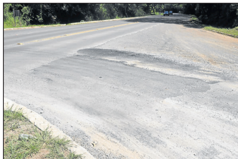
Serviço de tapa buracos foi melhorado no trevo da Major Bandeira
