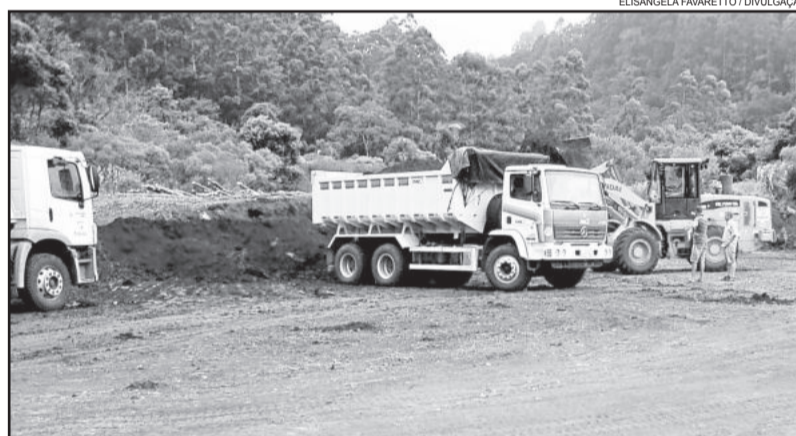
Terraplanagens auxiliam no avanço do setor primário
