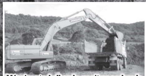
Máquinas trabalhando em ritmo acelerado
