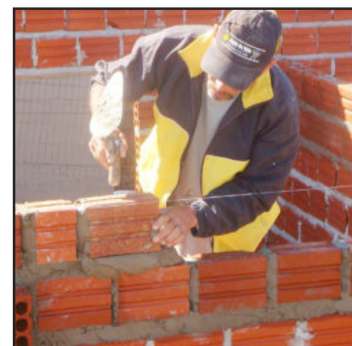
Serviços estão sendo executados por empresa terceirizada
