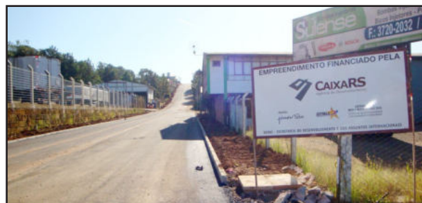
Obra de pavimentação foi concluída
