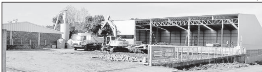
Languiru segue com obras de adequação no novo Centro de Distribuição, em Teutônia
