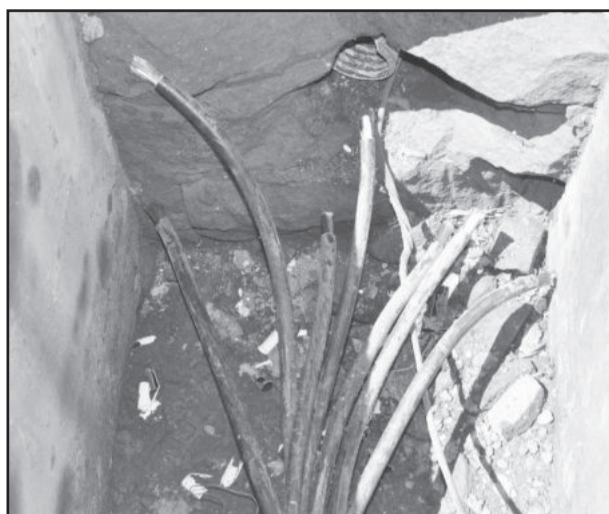
Fios foram cortados em dois pontos
