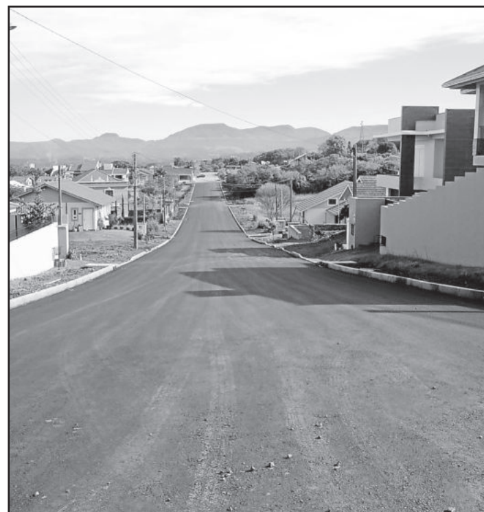
Rua Fredolino Bayer, Centro Administrativo
