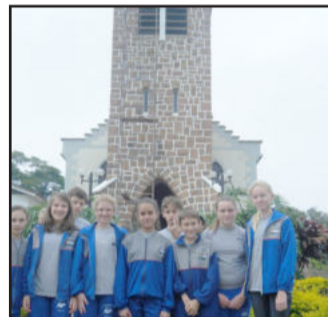
Alunos visitaram a Igreja São, que atualmente está em reforma
