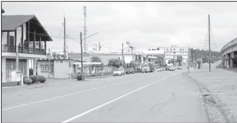
Boa parte das edificações está dentro da área não edificante
