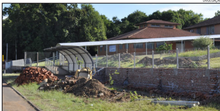
Melhorias no muro da EMEF Alfredo Schneider
