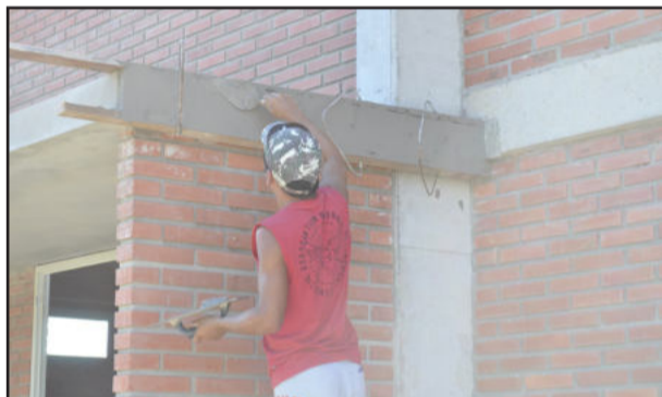
Equipe trabalha nos acabamentos externos
