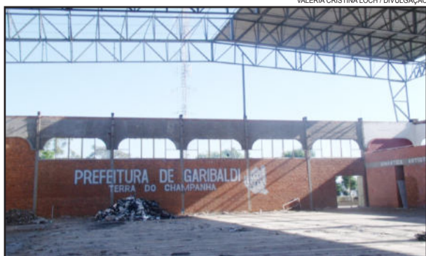
Ginásio Municipal de Esportes passa por reformas
