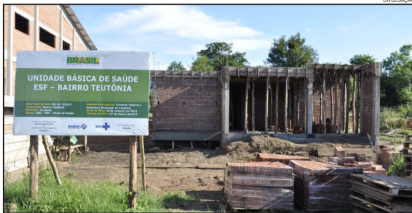
Novo Posto de Saúde do Bairro Teutônia está em obras
