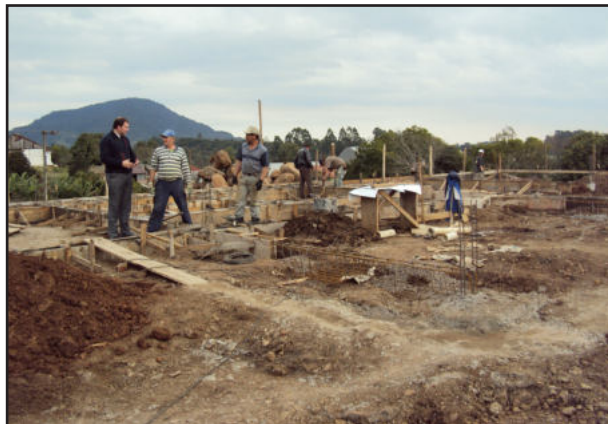
Obras já estão em andamento
