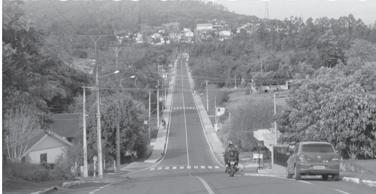
Estrada da Várzea contempla pista asfaltada e calçada para pedestres e ciclistas
