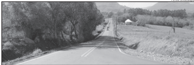
Obra de pavimentação em Linha Clara
