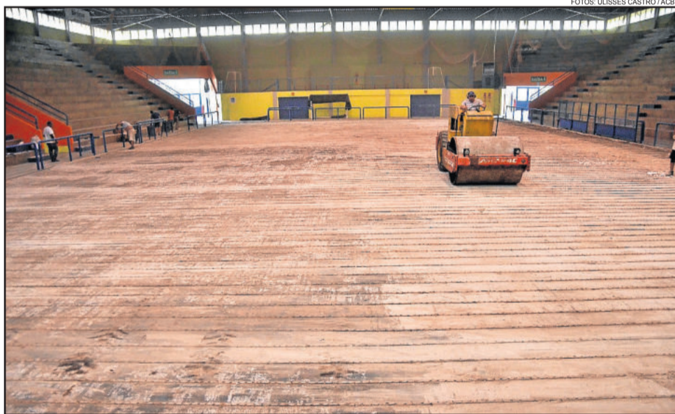
Piso antigo foi totalmente removido nesta semana
