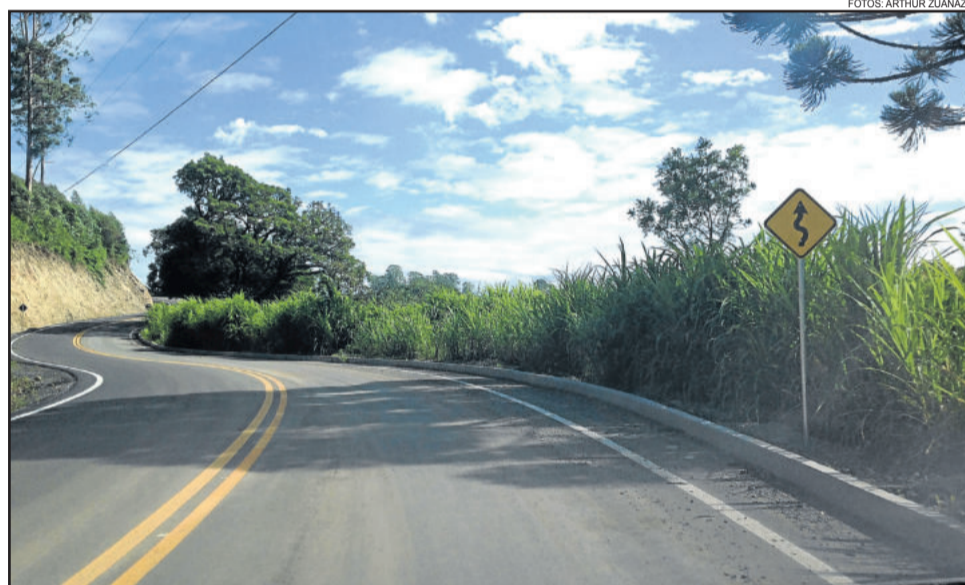
No local, já foi executada a terraplenagem, drenagem, pavimentação asfáltica e o acostamento no trecho de pouco mais de 1 quilômetro
