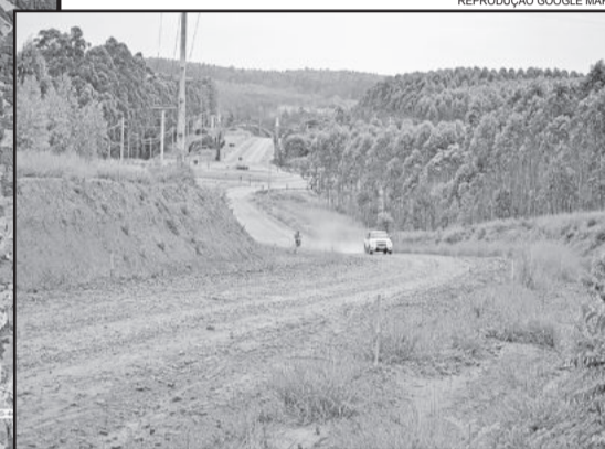
Estrada de Aterrados atualmente não tem pavimentação
