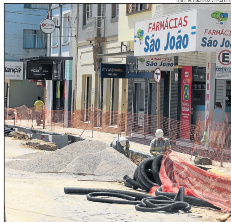
Segundo trecho que recebe a revitalização tem obras avançadas
