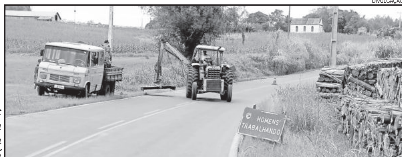
Serviços de limpeza foram realizados na VRS-835
