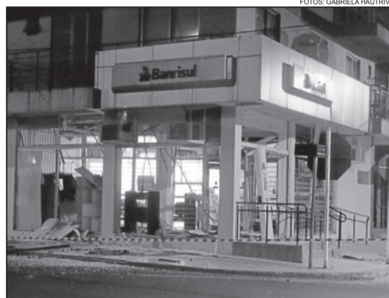
As duas laterais do local ficaram danificadas
