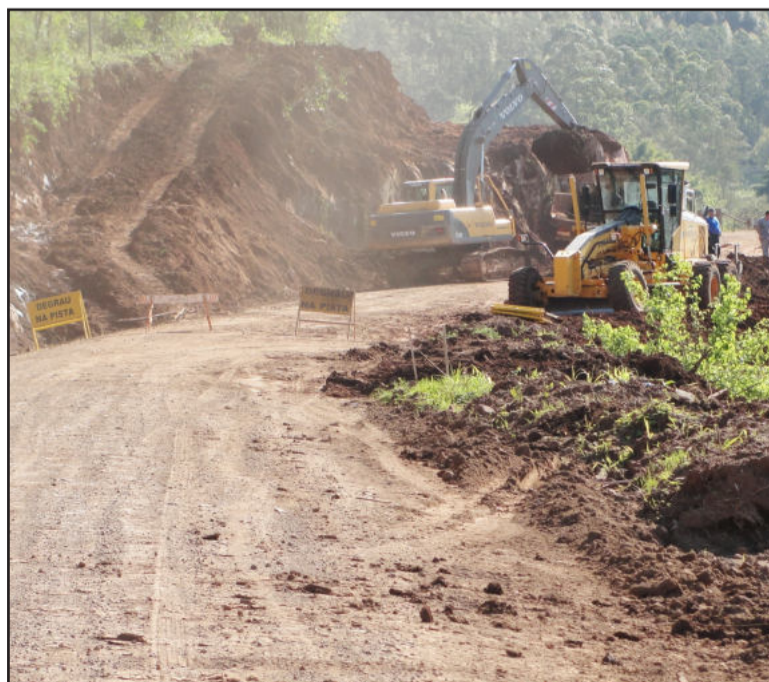
Obras do asfaltamento em Vitória até a divisa com o município de Montenegro estão em pleno andamento
