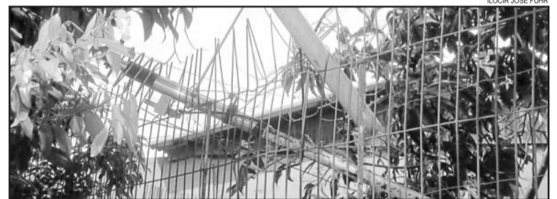
Antena caiu sobre fios de alta tensão
