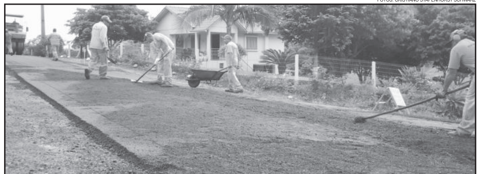
Asfalto sendo concluído na Linha Paissandu
