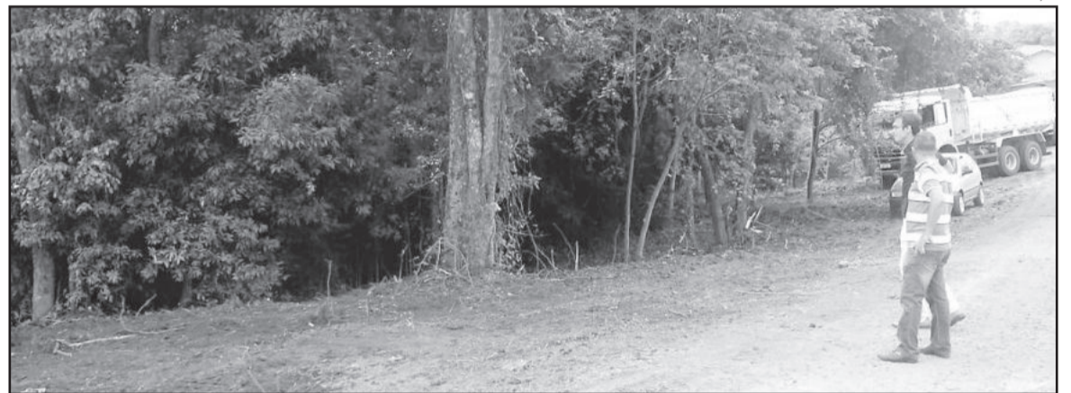
Evolução das obras de construção do Parque Ambiental no Bairro Alesgut
