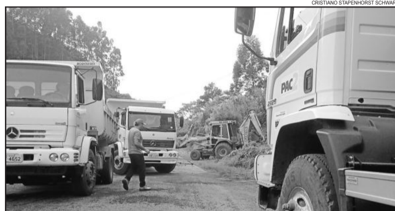
Secretário de Obras, Paulo Bagatini, coordena as equipes
