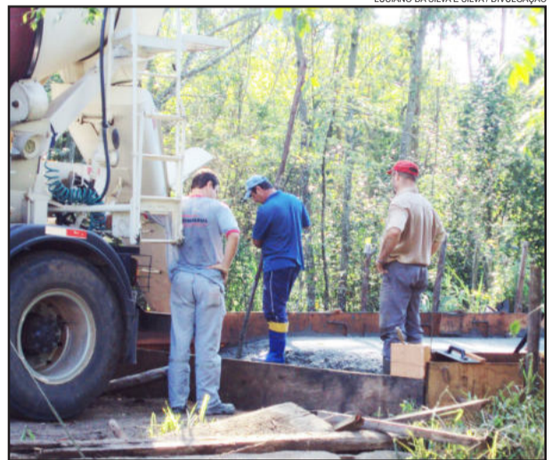
Ponte foi construída em concreto pela Prefeitura de Paverama
