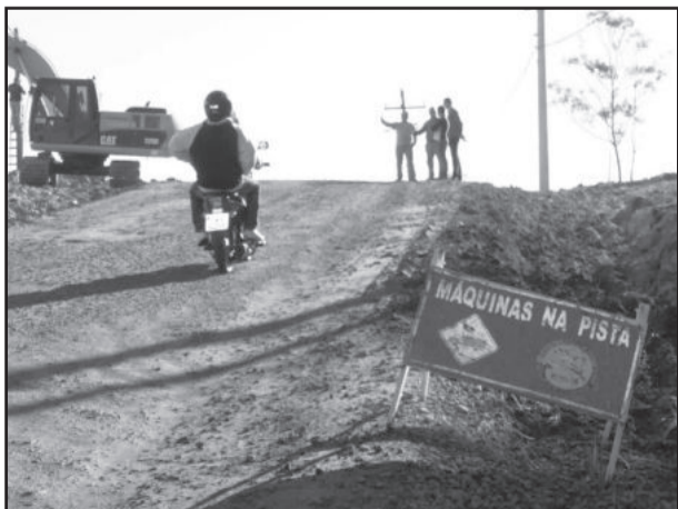
Obras tiveram início esta semana
