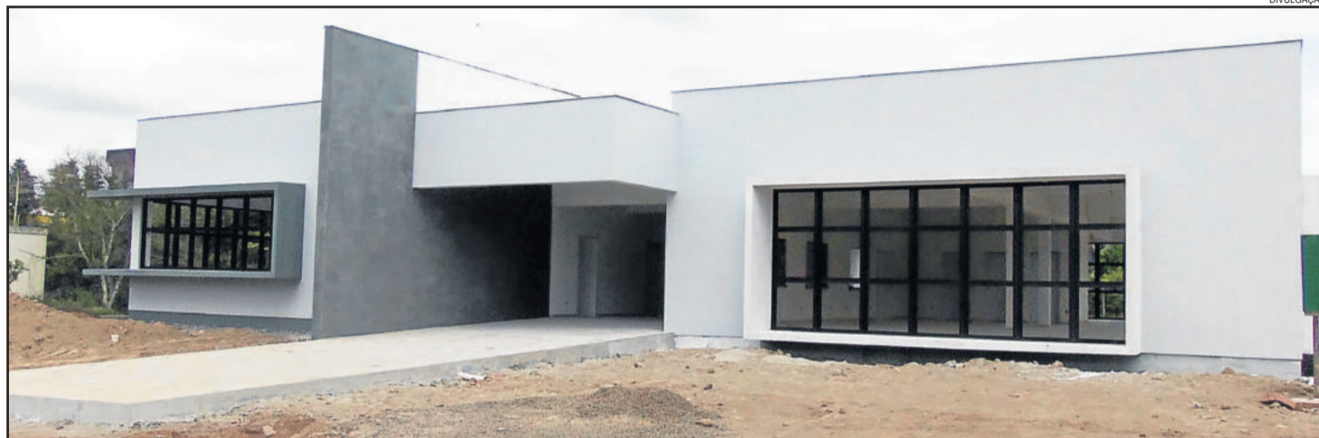
Nova Prefeitura está em reta final de construção
