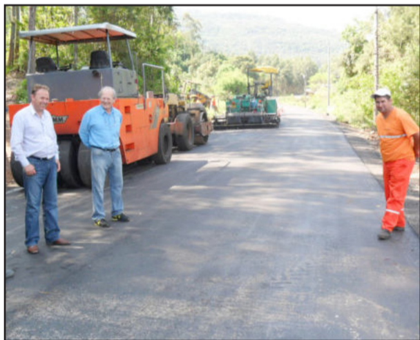
Obra na Transcitrus
