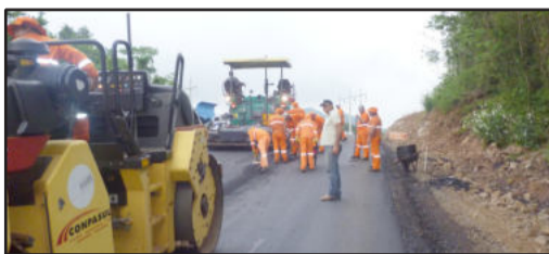
Secretário de obras, Paulo Bagatini, acompanha pavimentação de perto
